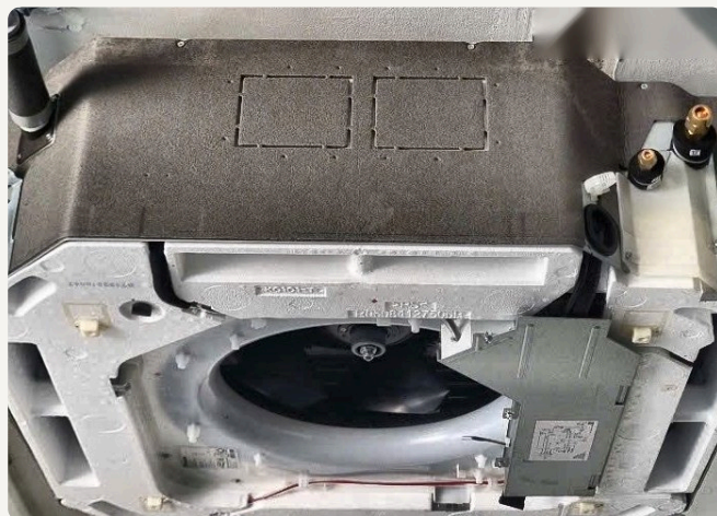
Treo dàn lạnh cassette – cân chỉnh trước khi lắp mặt nạ
