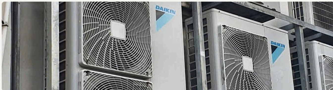
Cụm dàn nóng trên giá thép 2 tầng, đánh số từng máy theo dàn lạnh
